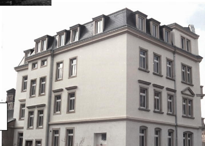
Hofbereich mit wiederentstandem Mansarddachgeschoß
