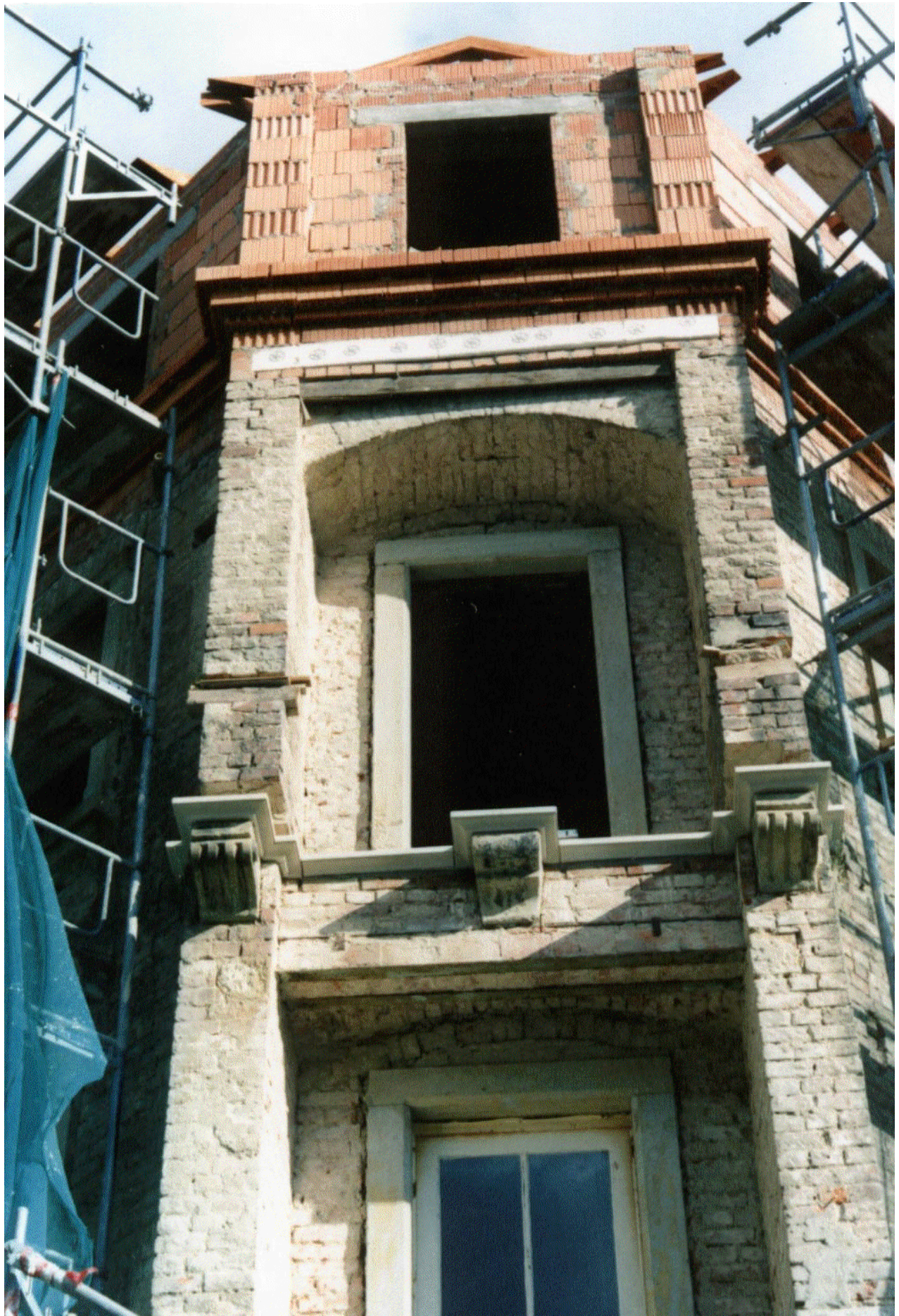
Balkone im Bauzustand
