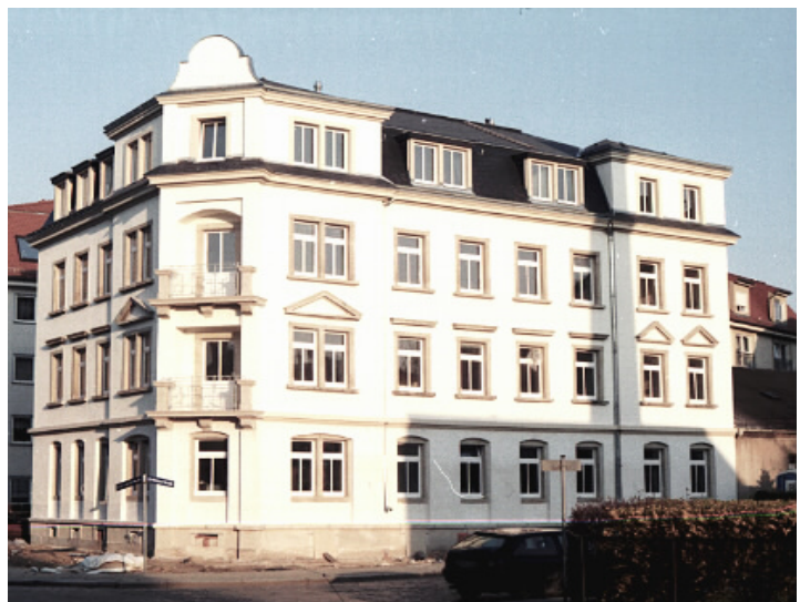
Zustand gegen Abschluß der Rekonstruktion April 97
