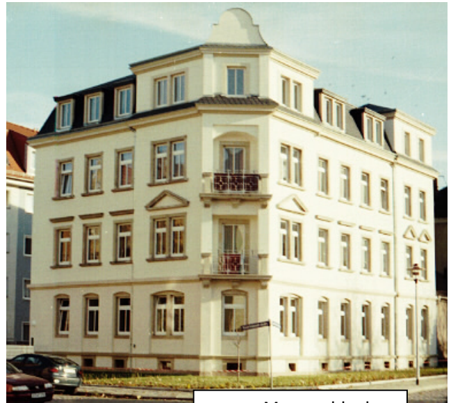
neues Mansarddach mit Ziergiebel
