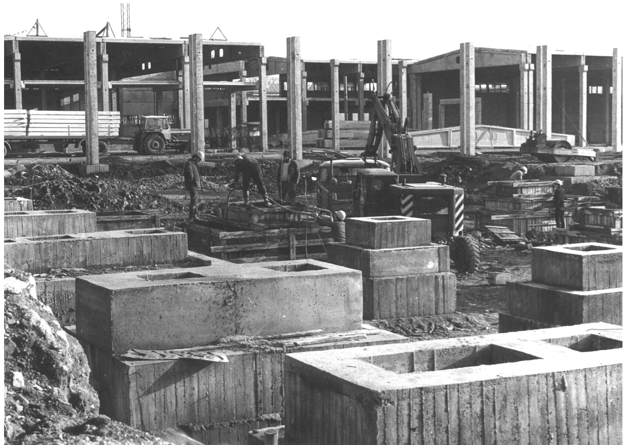
Stützen- und DachbinderMontagen für den Fleischverarbeitungsbetrieb
