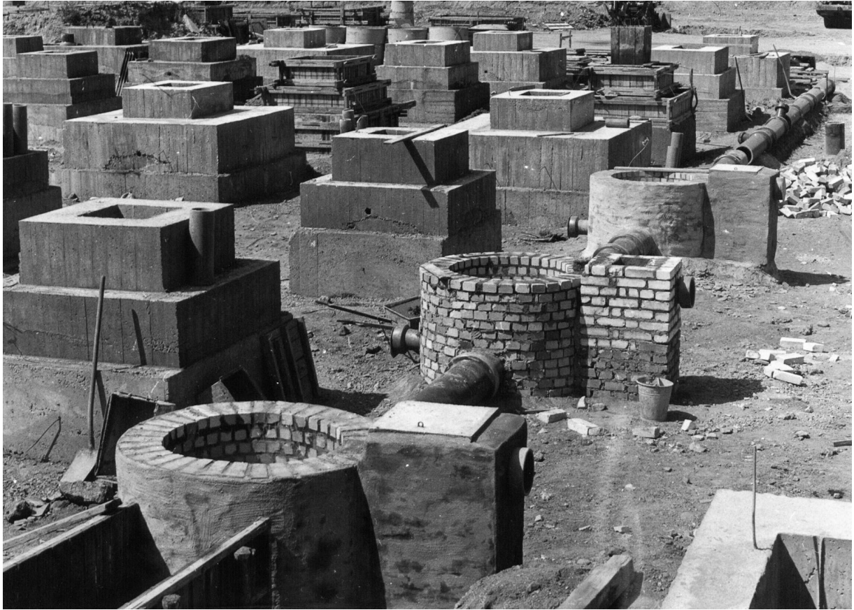
Fundamentierungen für den Fleischverarbeitungsbetrieb
